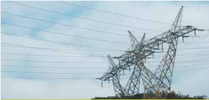
觸電或電殛-碰到或太接近架空高壓電纜
