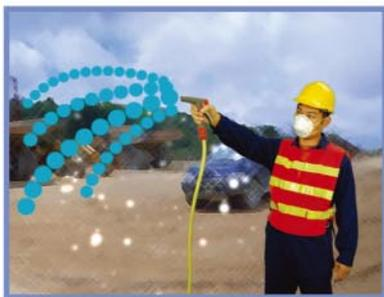
2. 在建築及拆卸工程中，適當採用濕抹法抑制石棉塵埃產生，有助預防僱員患上石棉沉着病及間皮瘤。
